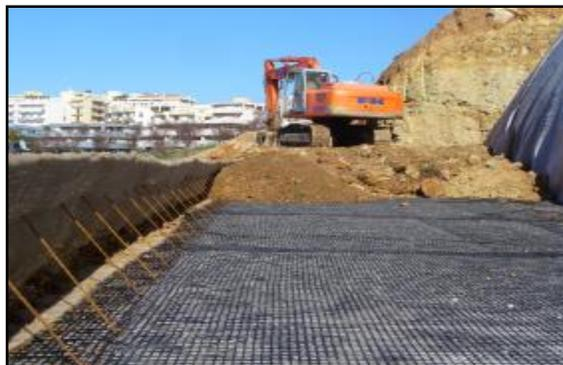
Posizionamento dei casseri, stesa del geotessile o della geogriglia di rinforzo, successiva posa della georete sul paramento esterno
