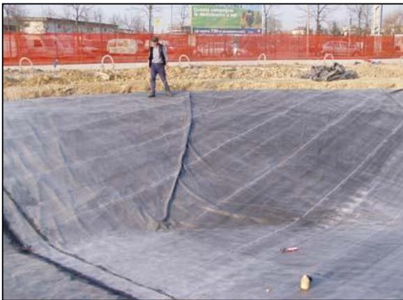
14. I teli di grandi dimensioni di EPDM si prestano ottimamente a bacini di forma irregolare: non sono necessarie saldature ma una semplice piega del materiale.
