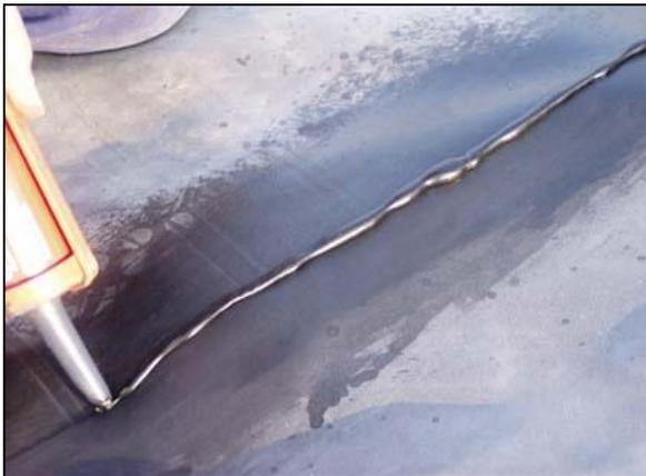
8. Pulire la membrana lungo il bordo della giunzione con il liquido pulitore “Weathered Membrane Cleaner” e stesa finale nel sormonto del sigillante nero “Lap Sealant”.
