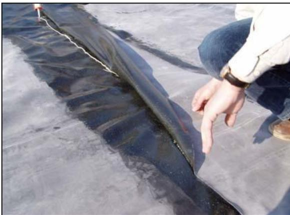
6. Attendere l'essiccamento del collante “Splicing Cement” e richiudere manualmente la giunzione evitando stiramenti e grinze.
