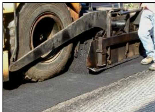
In ogni caso ROAD GRID non subisce alcun danneggiamento o alterazione da calore durante la posa in opera del conglomerato.
