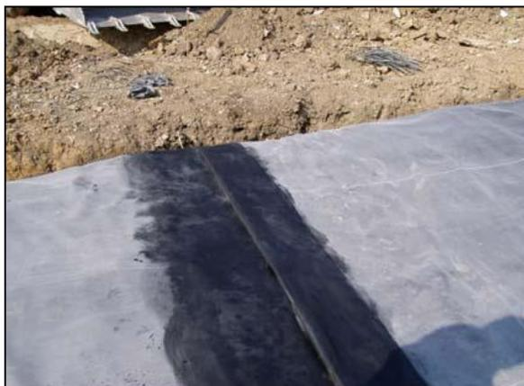
3. Pulire entrambi le superfici da accoppiare per una larghezza di almeno 20 cm con liquido pulitore "Weathered Membrane Cleaner".
