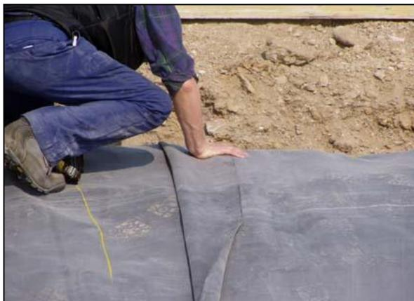
2. Segnare sul telo inferiore il limite del sormonto con gessetto e aprire il sormonto per almeno 20 cm.
