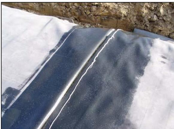
5. Stendere a 2 cm dal bordo esterno della membrana inferiore il cordolo sigillante “In Seam Sealant”.
